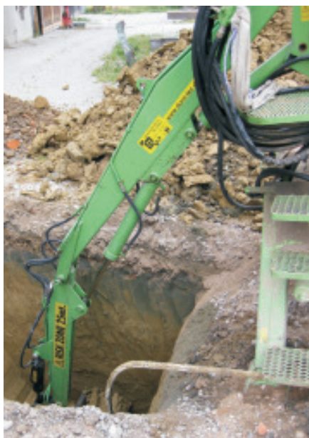
CLN при экскаваторных работах
